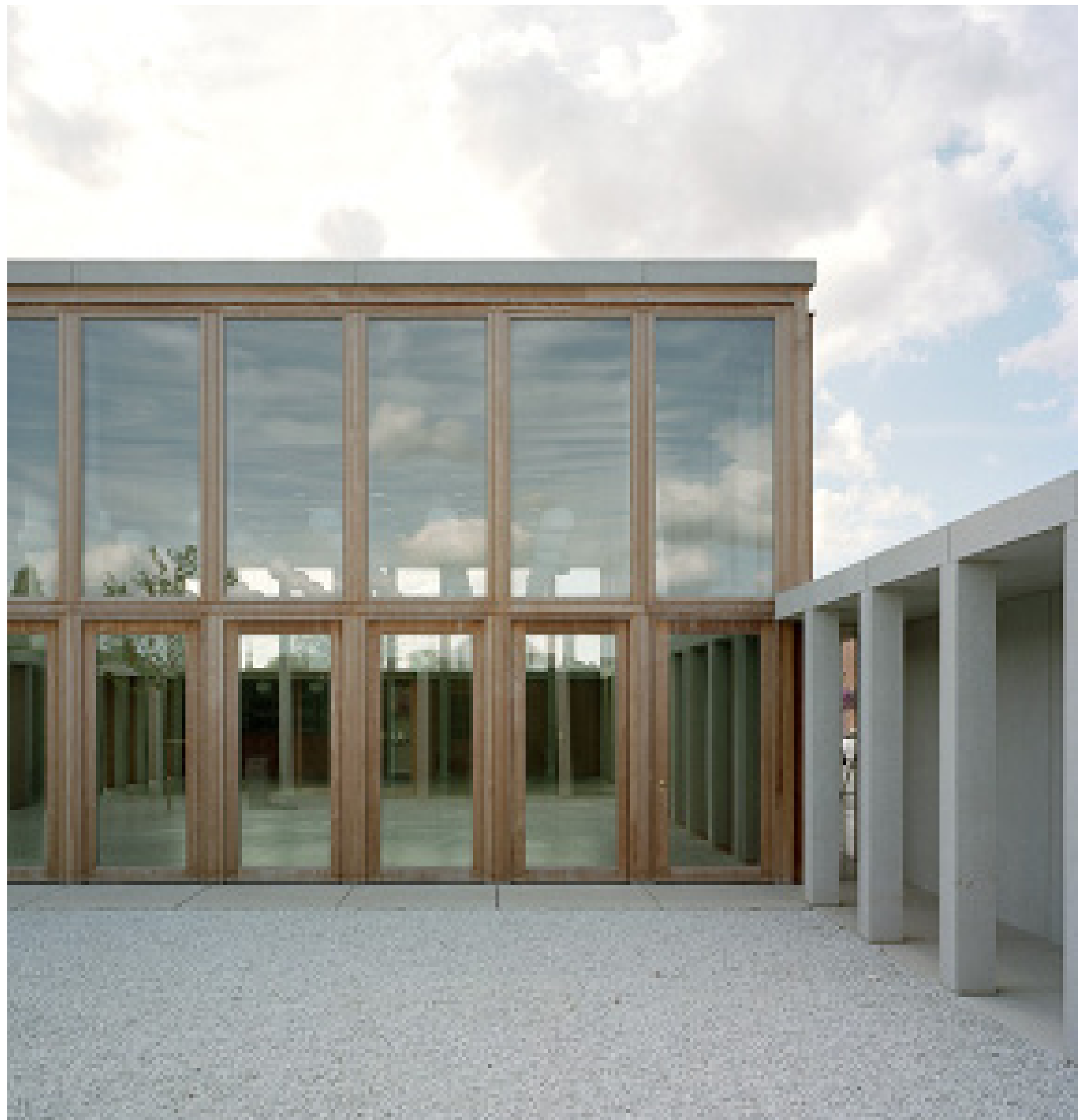
Die Glasfassade aus unbehandeltem Holz nimmt den strengen Rhythmus der Kolonnaden auf, verhilft ihnen aber zu einer freundlicheren Anmutung.
