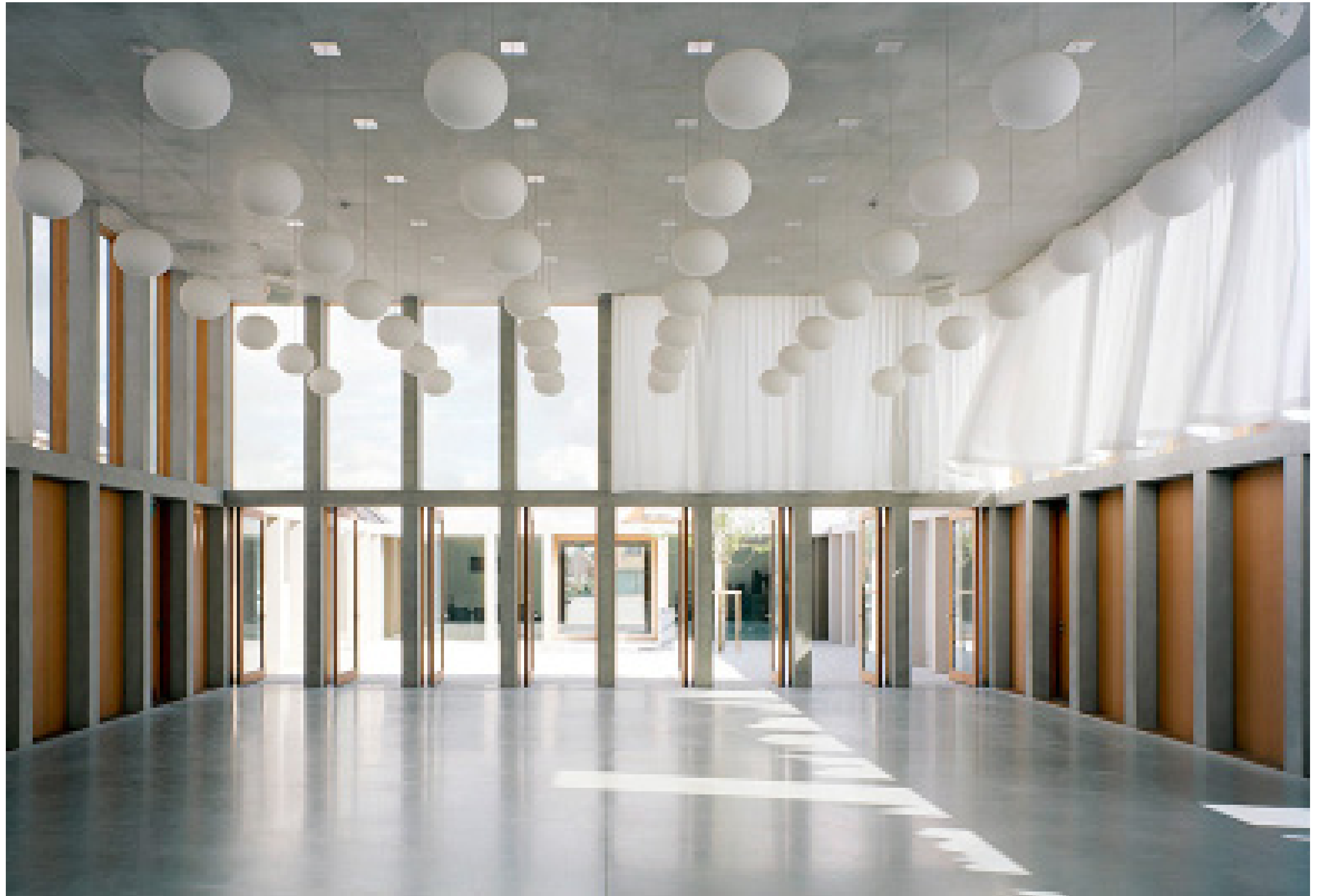
Der doppelgeschossige Gemeindesaal. Er wurde präzise in Ort-beton ausgeführt, während die niedrigeren Kolonnaden rundum vorgefertigt wurden.
